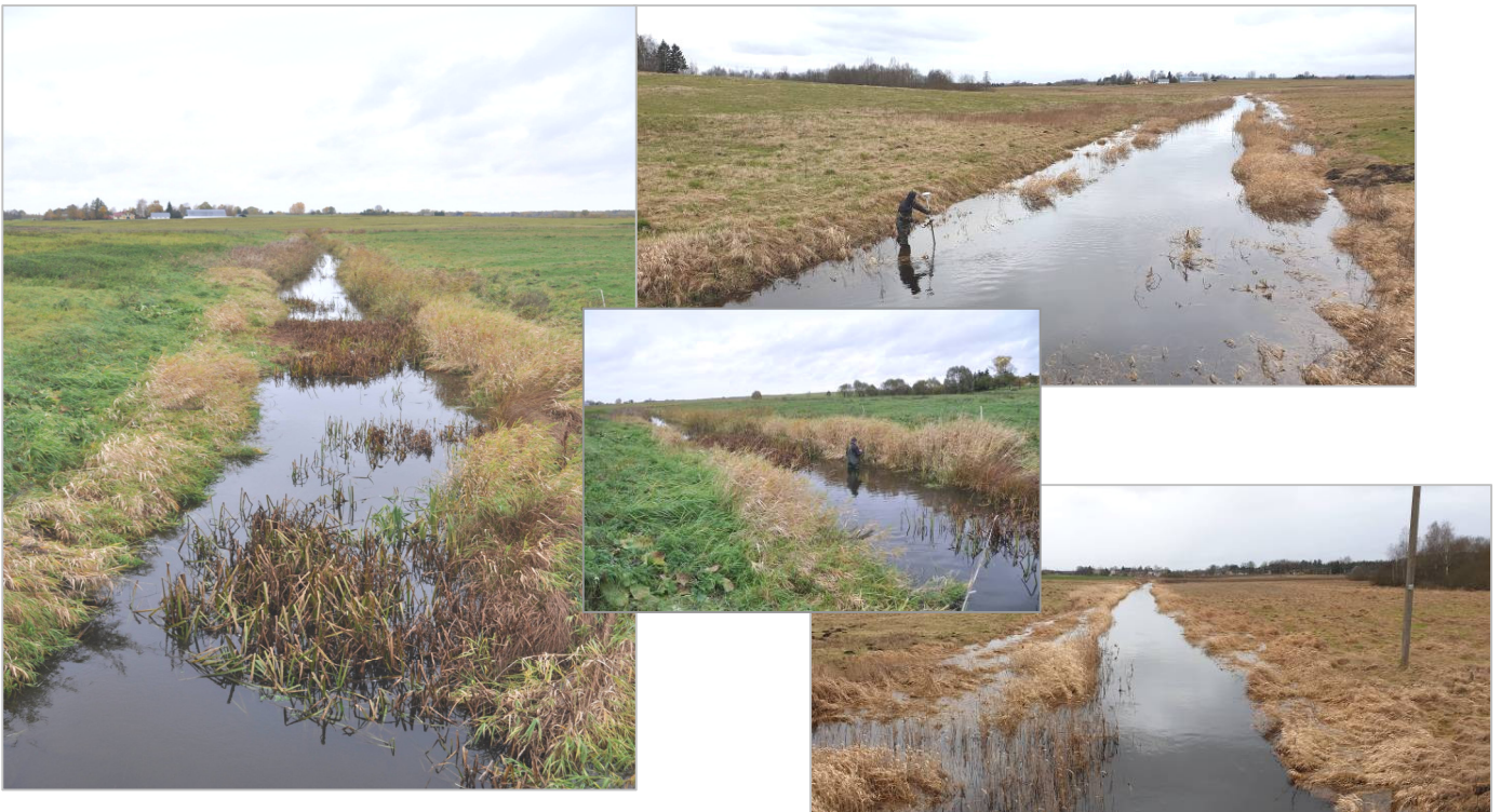
6 pav. Širvintos vaga ruože Nr. 2 tiesi, renatūralizacijos požymiai silpni (A. Balevičiaus nuotr.)
